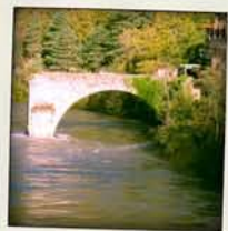
le pont cassé
